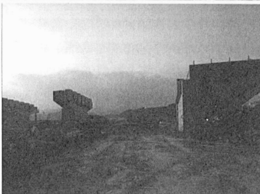
(写真4) 業者とともに応急復旧によって1日で修復された国道340号線(岩手県・陸前高田市)
