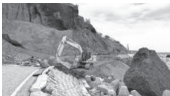
図4 道路啓開緊急工事
