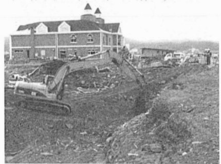
岩手県陸前高田市の道路復旧に全力をあげる国交省地方整備局の職員
