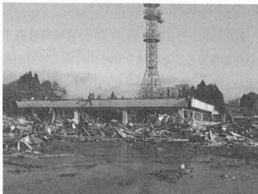
(写真 1) 東北地方整備局 仙台河川国道事務所 気仙沼出張所の津波被害の状況
